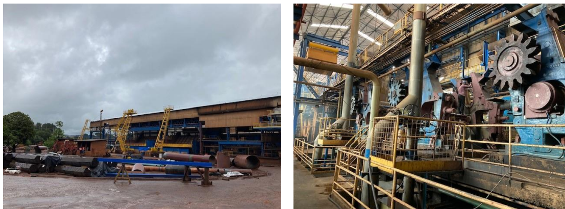
Figura 1 – Imagens registradas durante a visita técnica.
