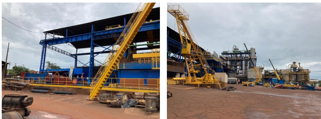
Figura 1 – Imagens registradas durante a visita técnica.
