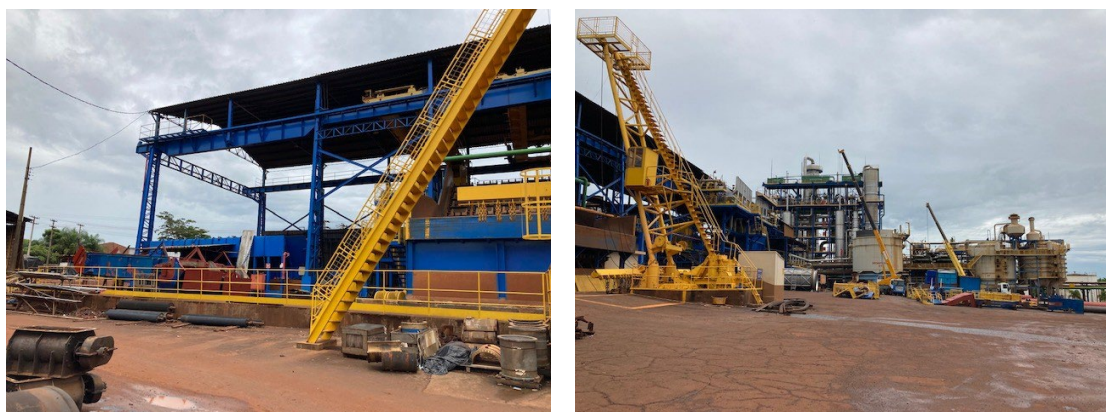
Figura 1 – Imagens registradas durante a visita técnica.
