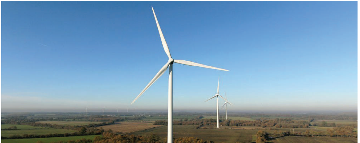
Le parc éolien de la Limouzinière en Loire-Atlantique
