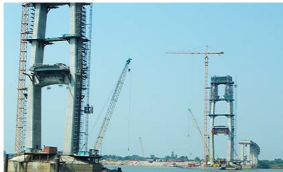
日本の支援で建設中のネアックルン橋 (2014年2月筆者撮影)
