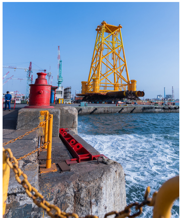
圖3 建造中風力發電海下基礎樁
