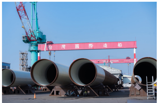
圖4 協助水下基礎樁管線防蝕工程
