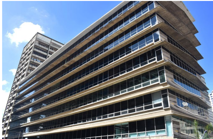
Edificio Atlantic en Los Palos Grandes, lugar de la segunda oficina de la Firma.
